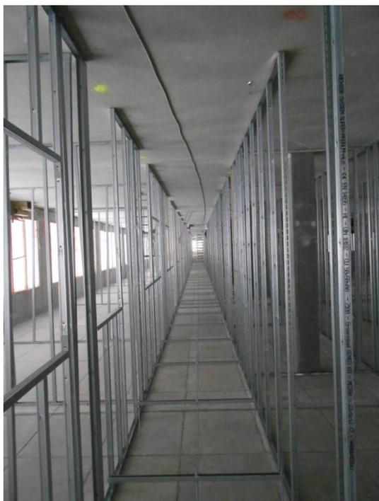
L'ensemble des travaux de parachèvement et de techniques spéciales ont tous démarré : chape, pose des demi-cloisons, intégration des techniques, pose des dalles flottantes, etc ... avancement méthodiquement.
